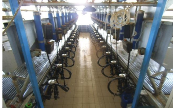
Süt Sağım Tesisi
