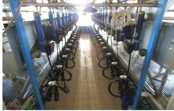
Süt Sağım Tesisi
