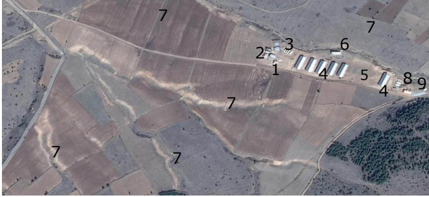
1- Yönetim Binası 2- Veteriner Ofisi 3- Yem Depoları ve Silajlık 4- Hayvan Ağıkları 5- 3 Adet Planlanan Hayvan Ağıkları 6- Süt Üretim Tesisi 7- Tarımsal Alan 8- Katı gübre atık deposu 9- Çoban Evleri
